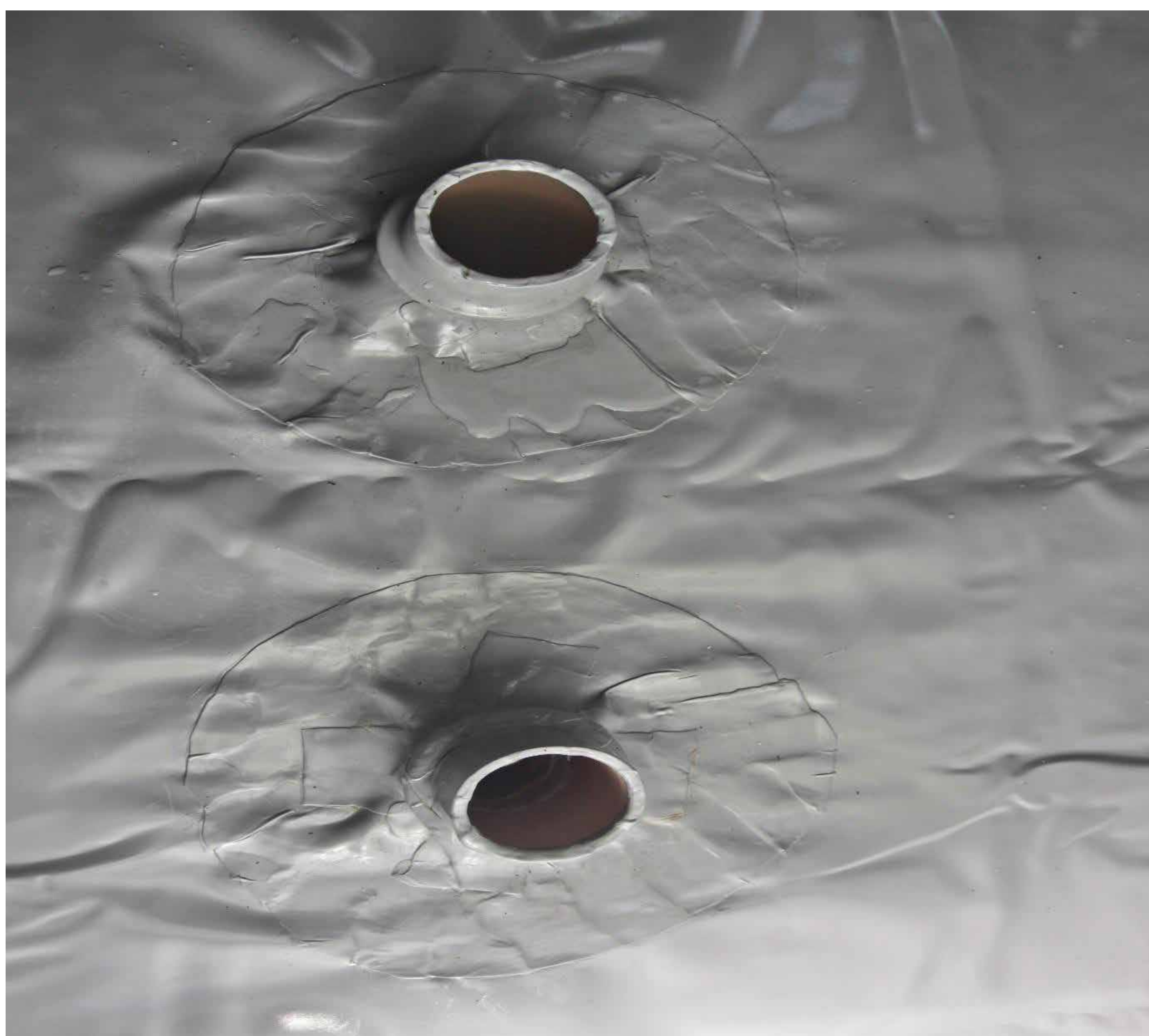
Revestimento das instalações hidráulicas
